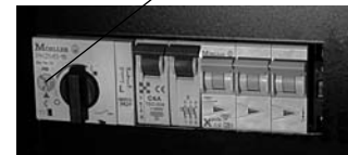
Nastavení tepelné ochrany motoru
